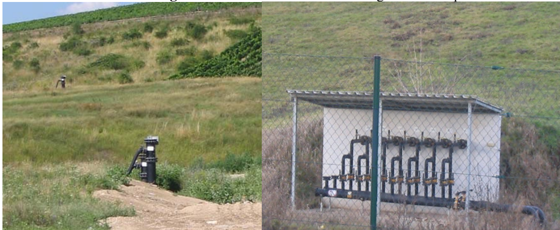
Figura 7. Put si sistem de colectare a gazului de depozit
