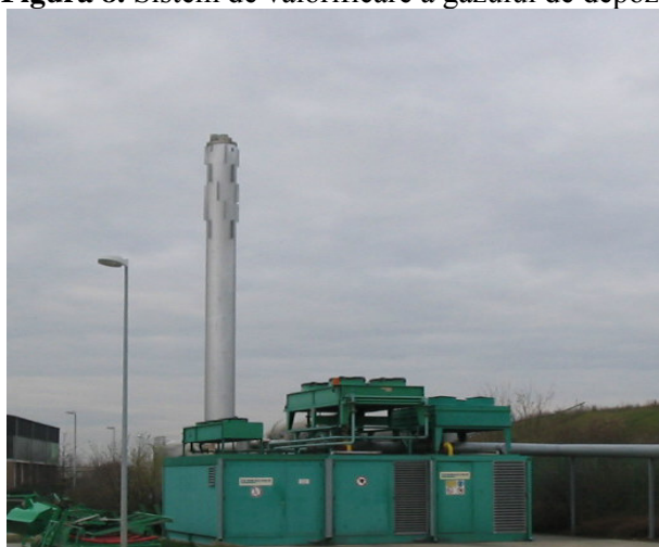
Figura 8. Sistem de valorificare a gazului de depozit
