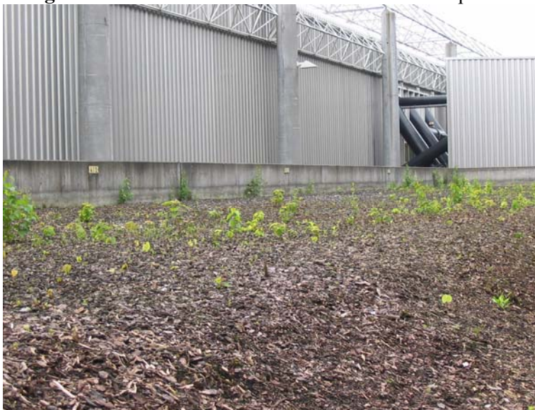
Figura 3. Vedere biofiltru utilizat la o statie de compostare
